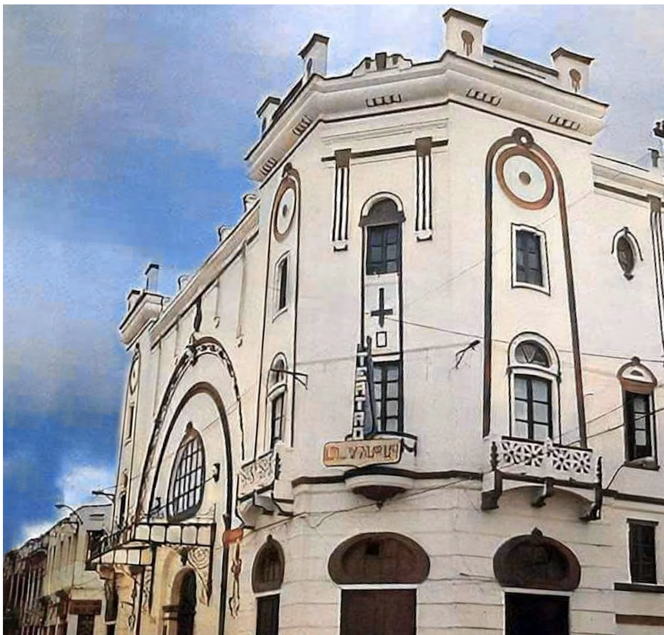
Fachada del Teatro Olympia de Manizales, edificado por los constructores de origen italiano Angelo Papio y Gian Carlo Bonarda. Perdida su función, el edificio fue demolido en los años setenta.
