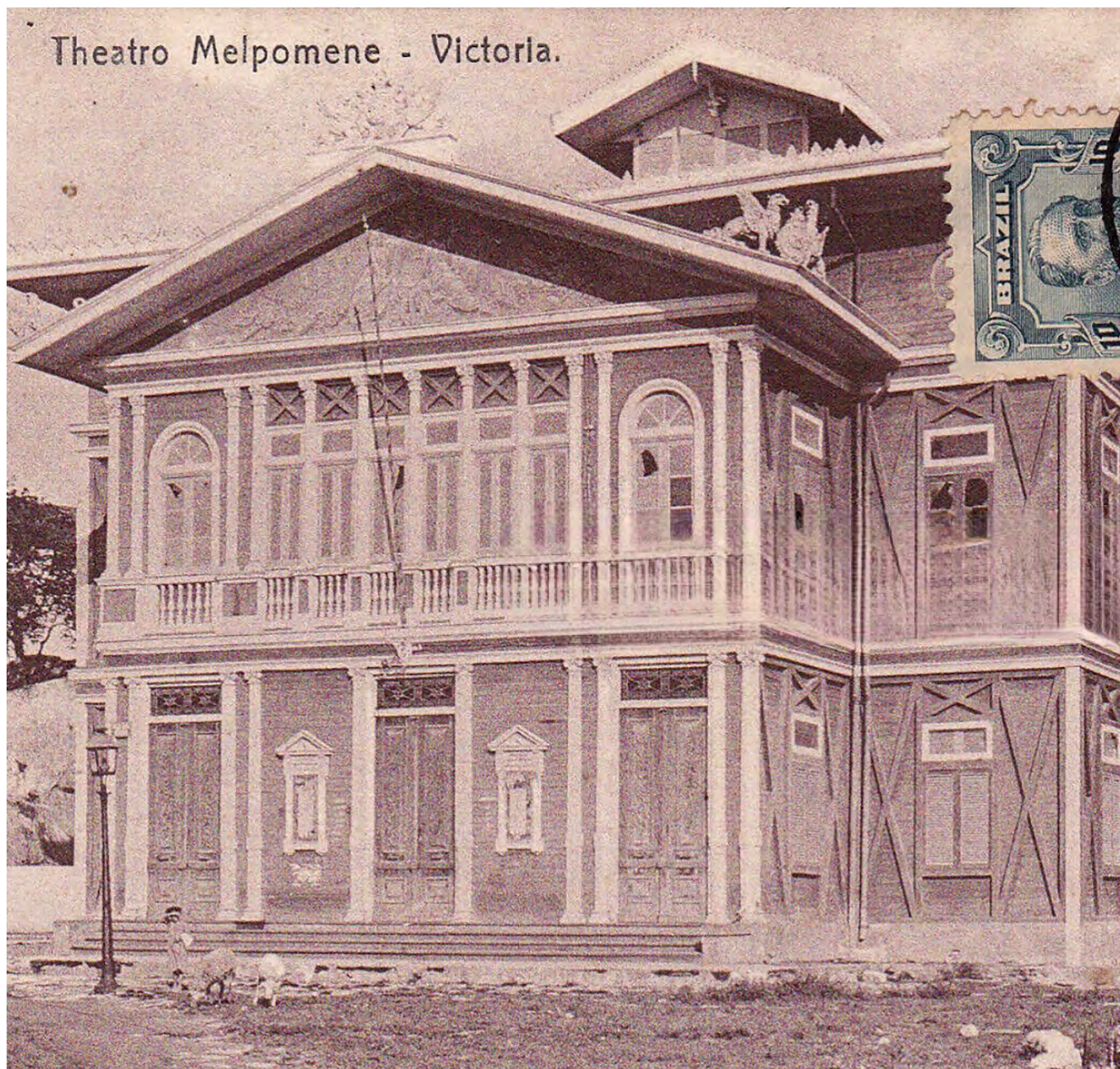
Fachada principal del Theatro Melpomene de Vitória, en una tarjeta postal. El 8 de octubre de 1924 el edificio sufrió un incendio que determinó que fuera cerrado y desmantelado poco tiempo después.
