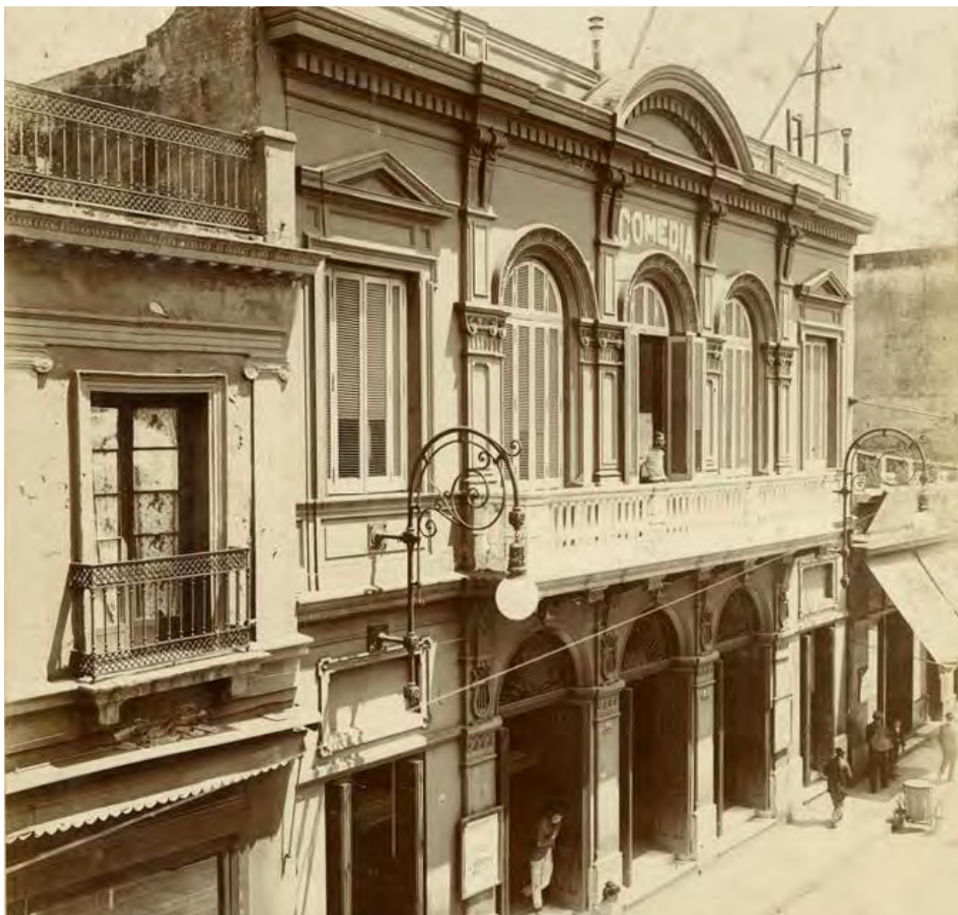
Situado en la entonces llamada calle de las Artes (hoy Carlos Pellegrini), entre Cuyo (hoy Sarmiento) y Cangallo (hoy Perón), el Teatro de la Comedia fue proyectado por el arquitecto originario de Génova Giovan Battista Arnaldi.
