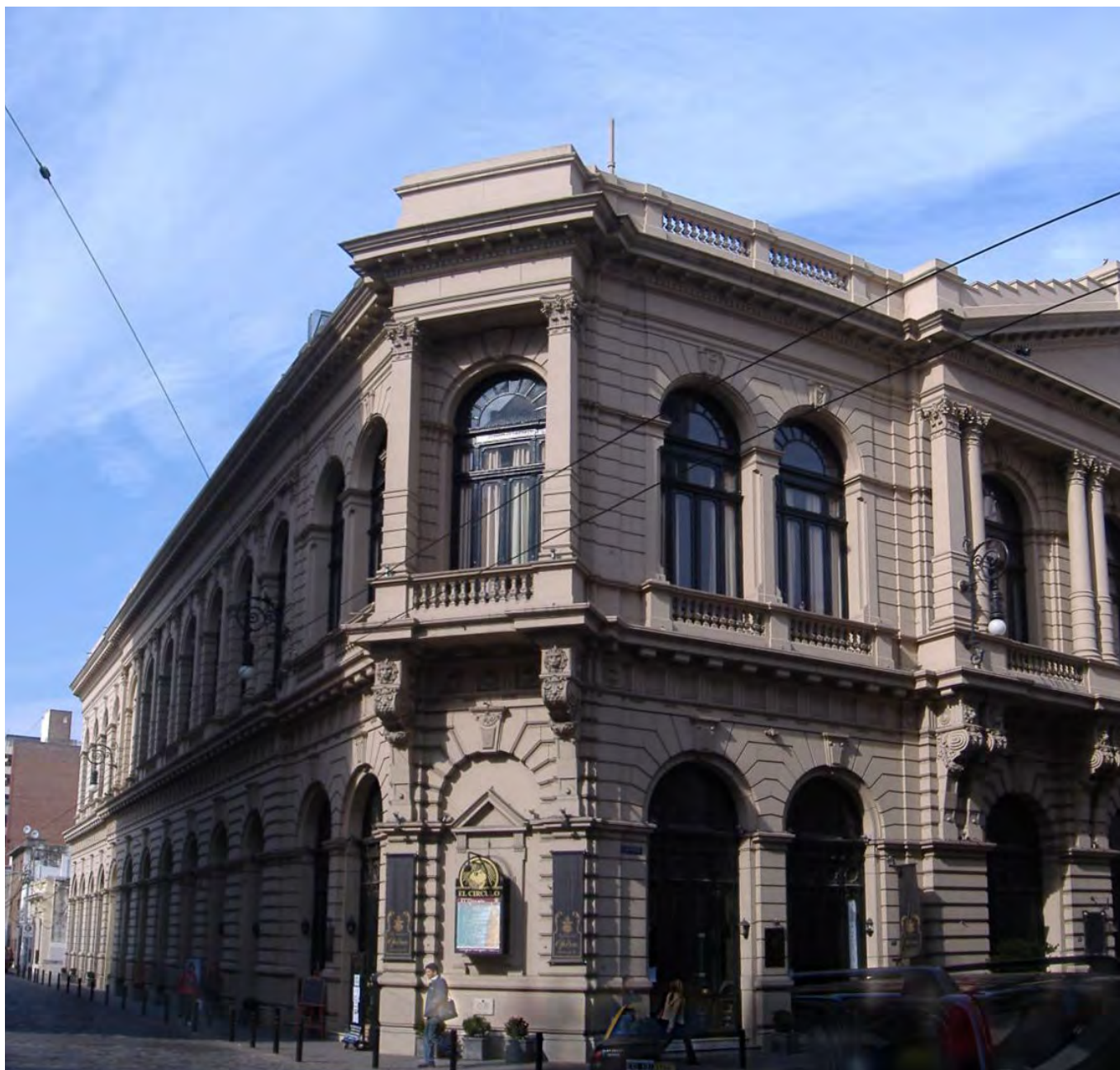
Fachada del Teatro de la Ópera, más tarde llamado El Círculo, inaugurado el 7 de junio de 1904, en una fotografía actual. El edificio fue proyectado inicialmente por Víctor Cremona y Silvio Contri y fue concluido por el arquitecto George Goldammer.
