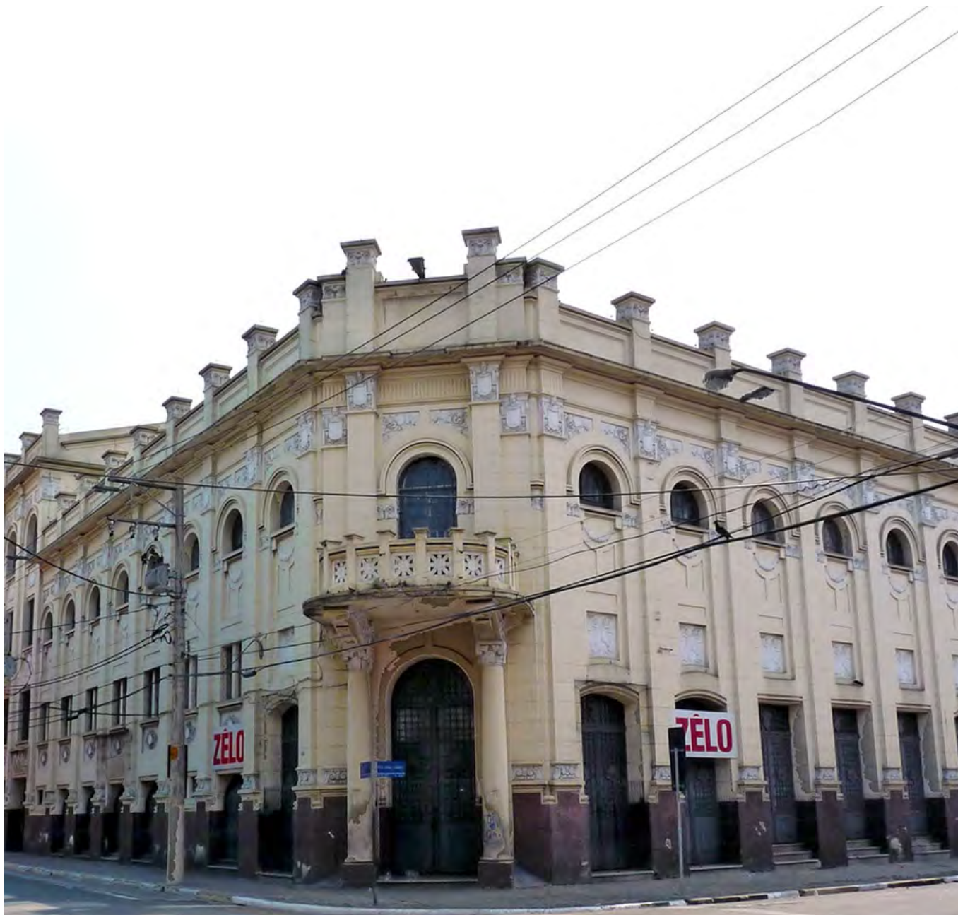
Fachada del Teatro Oberdan, diseñado por el arquitecto italiano Augusto Bernardelli Marchesini en 1929, en la actualidad transformado para ser utilizado como almacén comercial.
