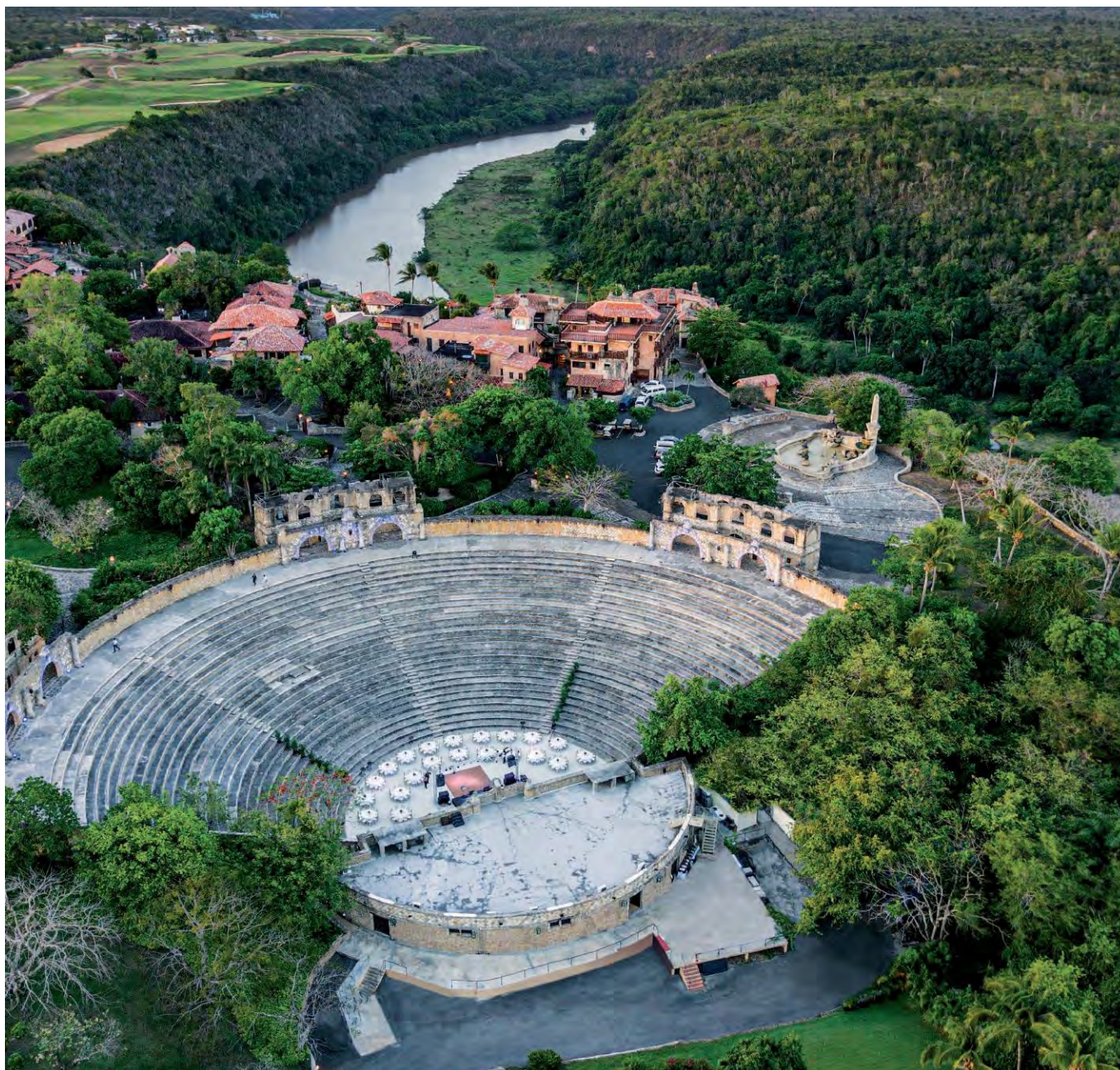
Vista aérea del Teatro al aire libre de Altos de Chavón, realizado en la década de los setenta, junto con el resto del poblado en estilo mediterráneo.
