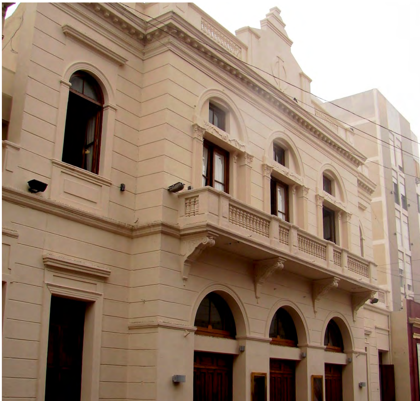
Fachada del Teatro Municipal de Río Cuarto en una fotografía reciente. El edificio fue proyectado entre 1905 y 1908 por el arquitecto genovés Giovan Battista Arnaldi.
