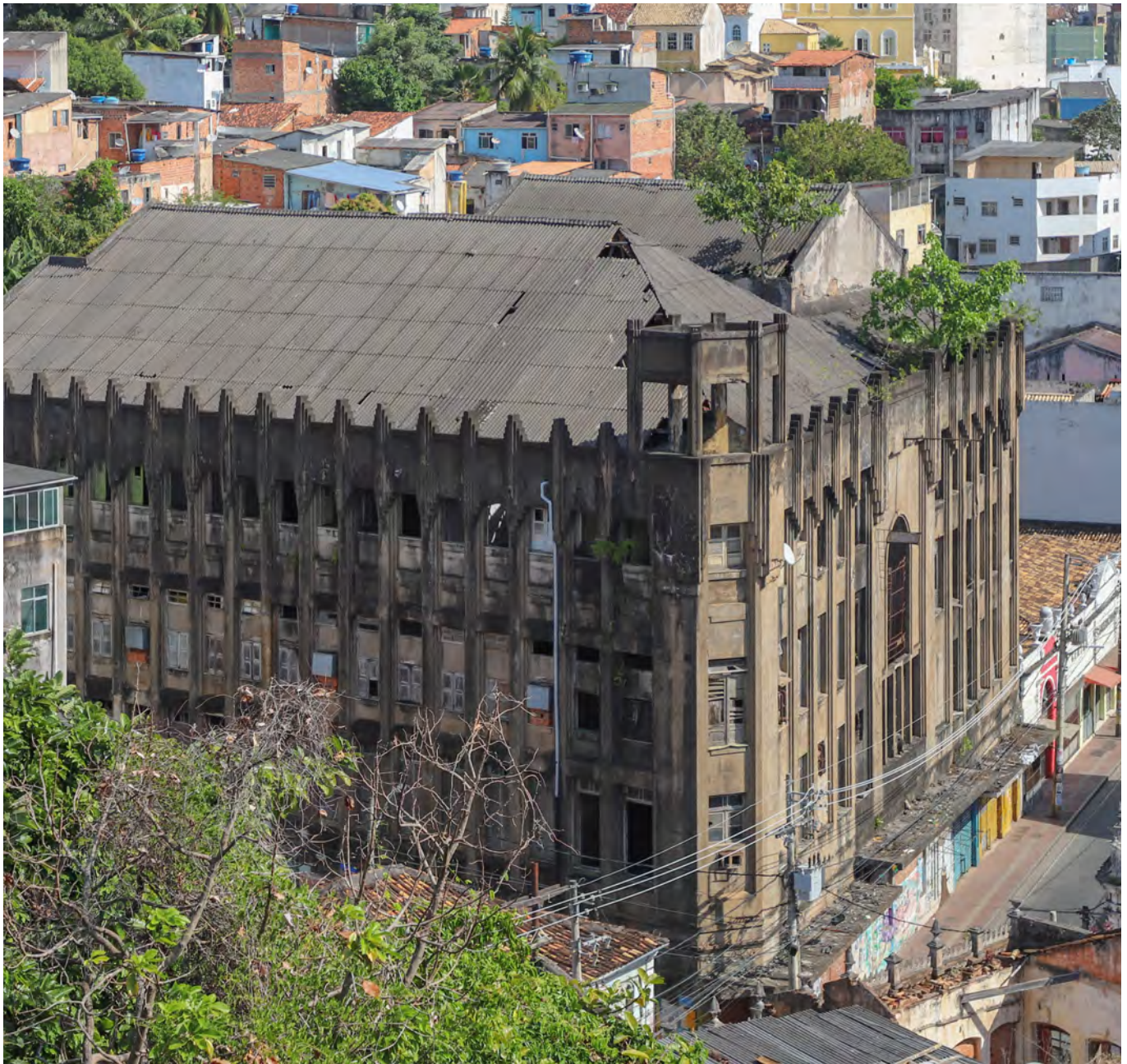
Cine Teatro Jandaia de Salvador de Bahía en una foto actual que muestra el estado de avanzado deterioro y abandono en el que se encuentra el edificio.
